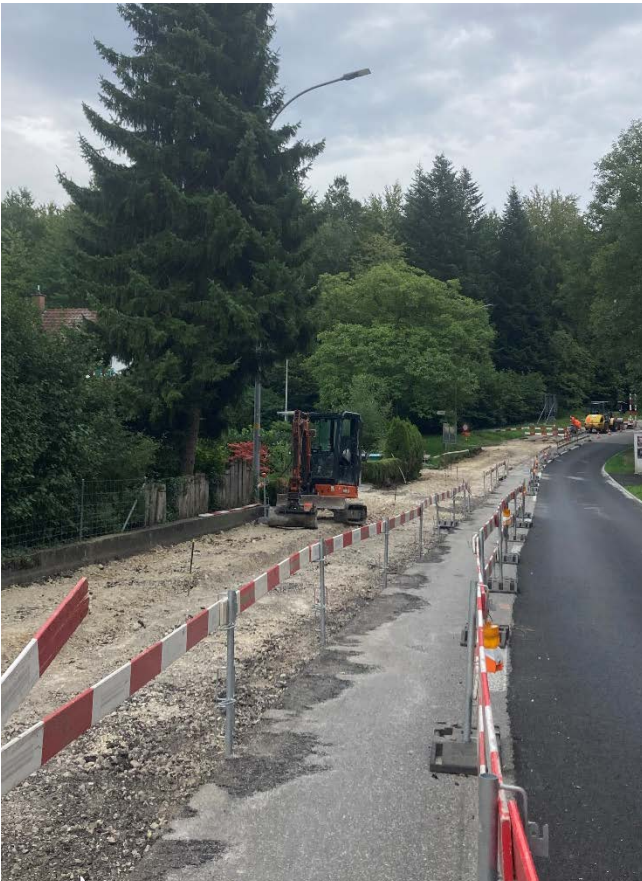
Abbildung 22 Objekt-Nr. 2.31, 1 Nussbaum, Dorfeinfahrt Süd Ortsteil «Dorf»
