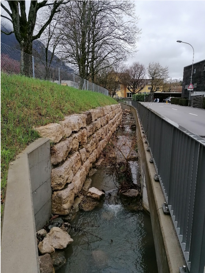
Abbildung 6 Objekt-Nr. 1.05, Chesselbach, Abschnitt altes Schulhaus / Hauptstrasse
